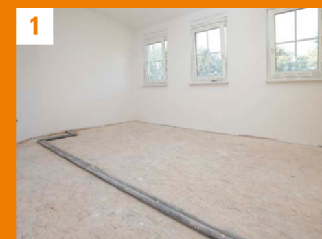
1 Verlegen des Randdämmstreifens Laying edge insulation strip
