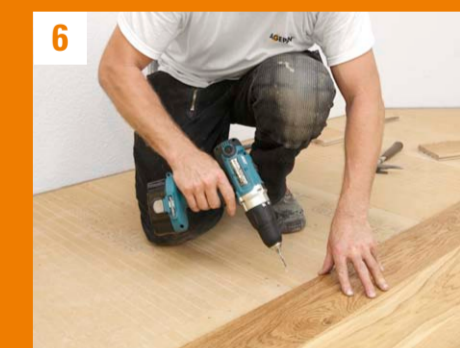
6 Hobeldielen können direkt in die MDF-Feder verschraubt werden Flooring boards can be screwed directly into the MDF stripes
