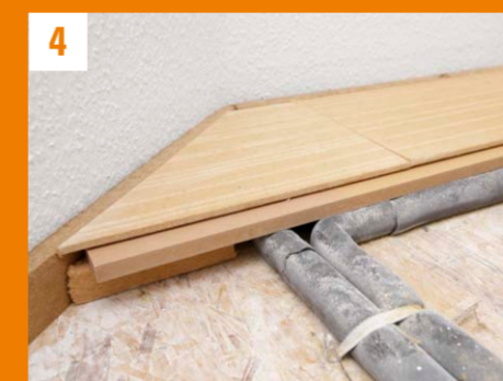
4 Keine Schall- und Wärmebrücken durch die in der Platte liegende MDF-Feder No acoustic or thermal bridges thanks to MDF strip within the boards
